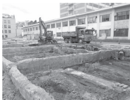
B. 表土はぎの様子(遠景:南東より)
