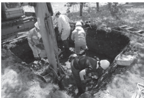
A. 調査の様子 1 (TP02: 北東より) 1806
