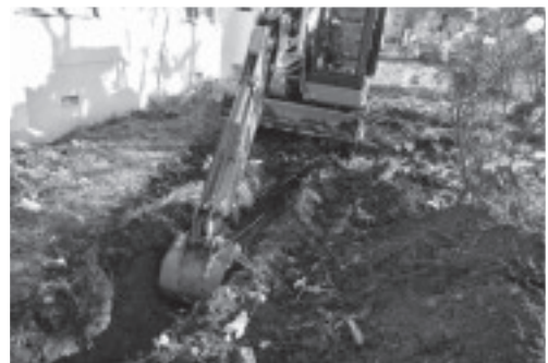
H. 中央第二宿舎給水設備改修工事（西より）調査番号：2018
