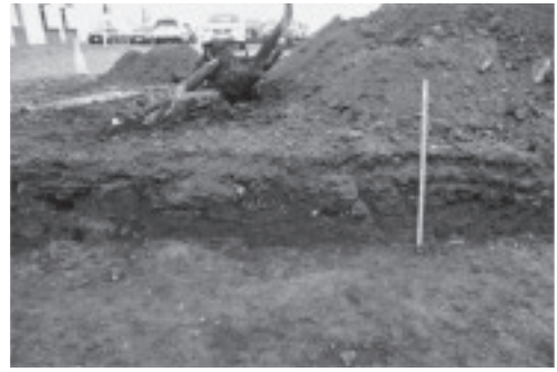
B. 医学部車庫新営工事（南より）調査番号：2008
