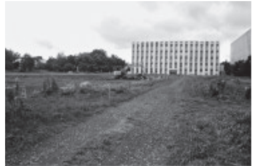
D. 調査状況（TP14 遠景：北より）
