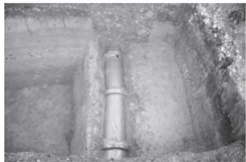
H. TP 16 土管 (東より)
