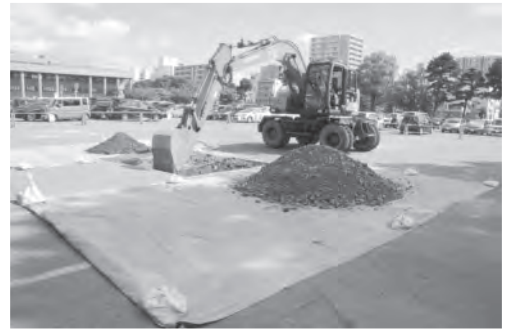
B. 調査の様子（TP02：南西より）
